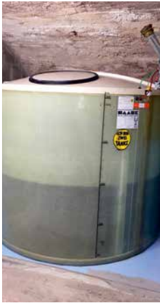
Haase-Kellertank (standortgefertigt)
